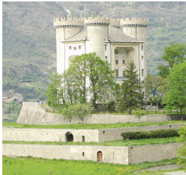
Sono iniziati i lavori per il recupero del castello di Aymavilles
